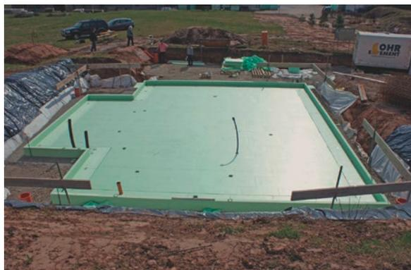
ISOLOHR - eine gedämmte Bodenplatte die gleichzeitig Schalung ist, fast zeitaufwendige Teilarbeiten zusammen. Mit der kurzen Aufbauzeit ergibt sich ein deutlicher Baukostenvorteil. Der Bauherr profitiert von einer dauerhaften Energieeinsparung.
